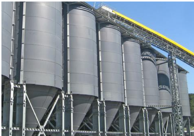
Sili di stoccaggio degli aggregati esterni
