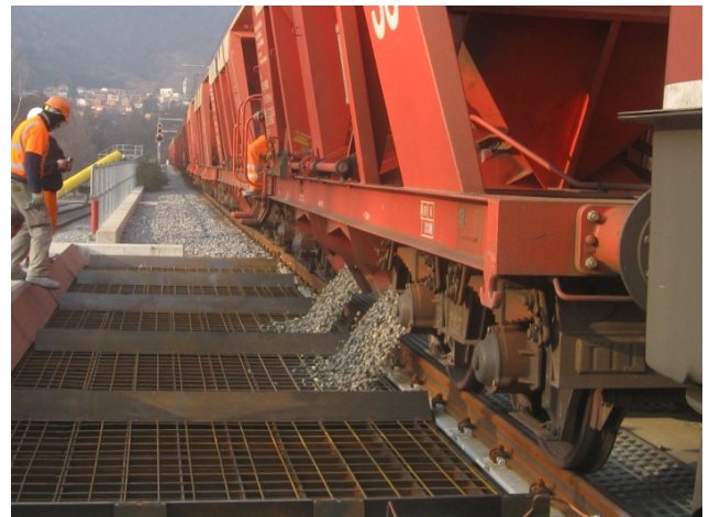
Raccordo ferroviario Sigirino: scarico aggregati esterni
