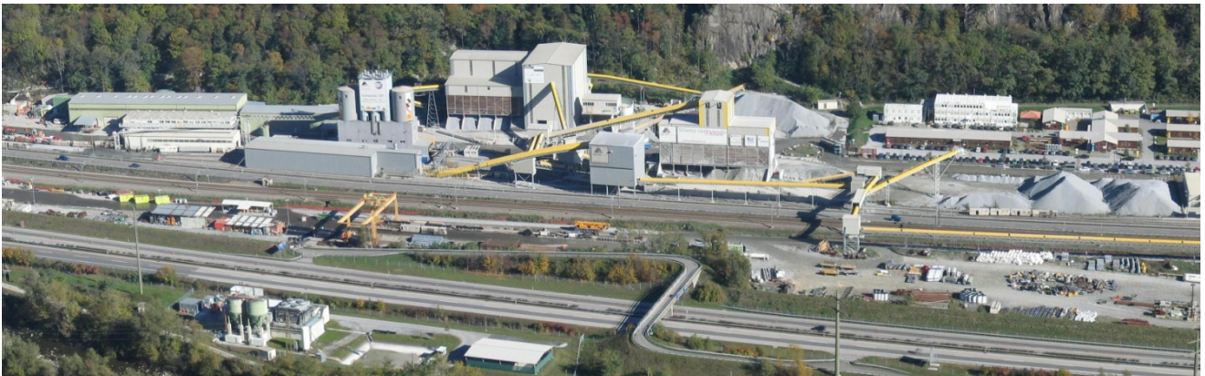
Impianti Gestione Materiale Bodio
