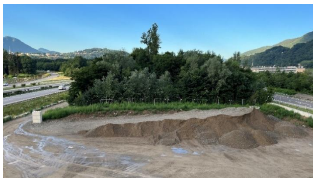
Deposito di materiale 0/45 mm certificato
