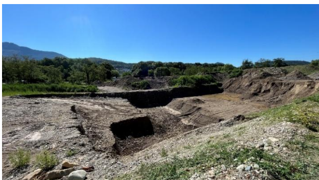
Particolare dell'area di scavo in zona di protezione della falda
